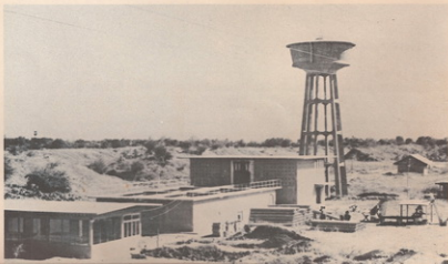
การประปา Water works
