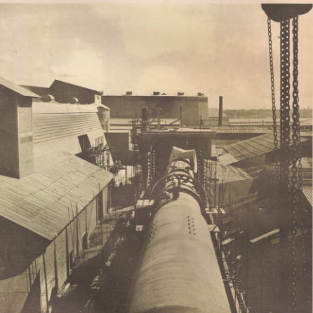
การติดตั้งหม้อเผาปูนเม็ด พ.ศ. ๒๕๐๖ Erection of a new rotary kiln 1963
