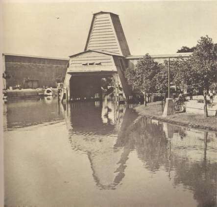
✕ กำลังขนเบตทางเรือ Loading cement into boats
