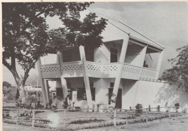
บ้านถักนอช่าง Engineer's house
