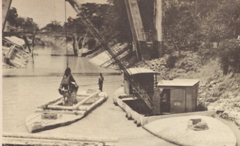
เลน คือ ดินดำที่ ได้จากแม่น้ำลำคลอง Silt excavating
