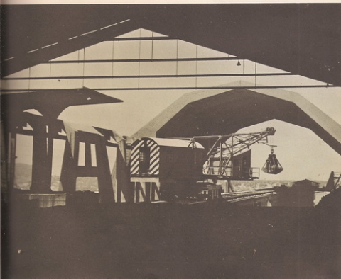
Кран в работе Crane at work
