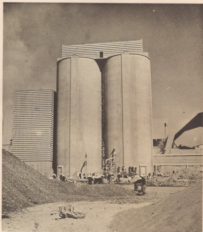
ถังปูนซีเมนต์ 4,000 ตัน Cement silos, 4,000 tons each
