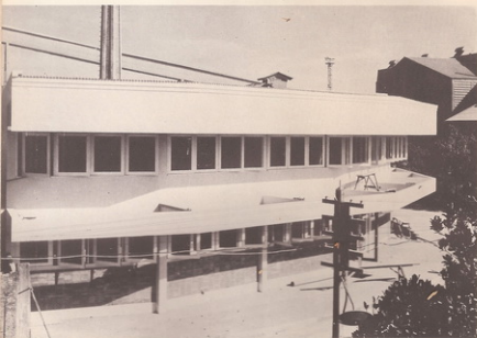
ทำการเกษตรระหว่างก่อสร้าง Engineers' office under construction
