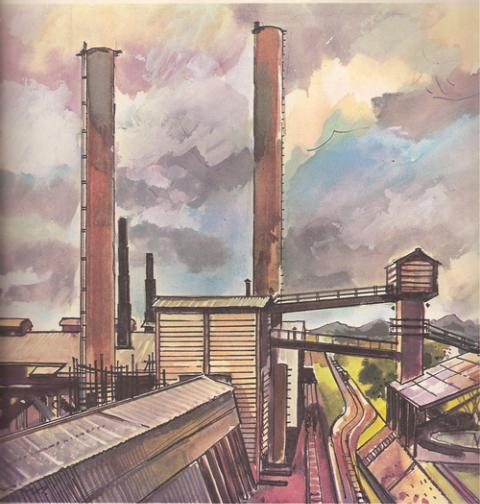
ภาพจากอดีต เป็นขณะทำหม้อเผาที่ ๒ อยู่ระหว่างก่อสร้างในปี ๒๔๕๕ Second kiln under construction, 1952
