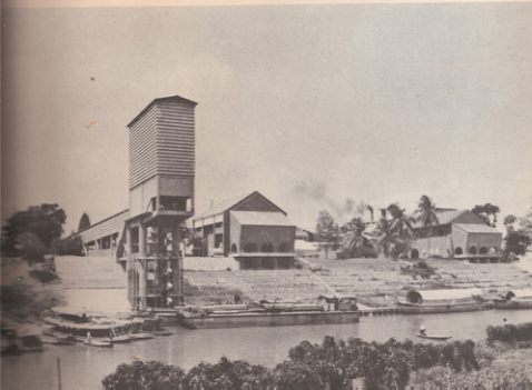
ถังซีเมนต์ทางเรือ Loading cement into boats
