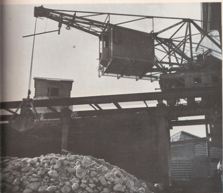
การลำเลียงหินยิปซัมด้วยปั้นจั่น Transport of gypsum by crane
