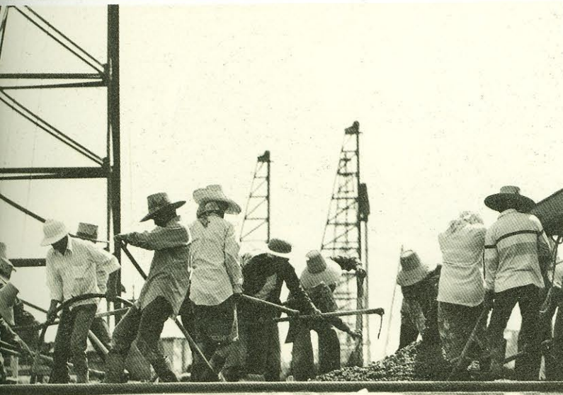
ผลิตภัณฑ์คอนกรีตของบริษัทผลิตภัณฑ์และวัสดุก่อสร้าง จำกัด (บนขวา) งานสร้างทางรถไฟสายฉะเชิงเทรา- สัตหีบ (ล่างขวา)
