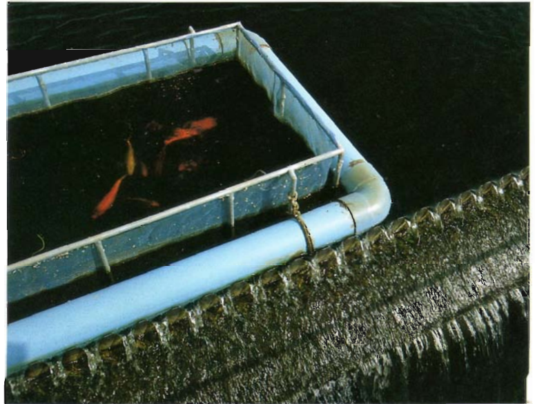
ระบบบำบัดน้ำทิ้งของกลุ่มเยื่อและกระดาษ ก่อนปล่อยน้ำที่ผ่านการบำบัดจนสะอาด ตามหลักเกณฑ์ที่กำหนดลงสู่แหล่งน้ำสาธารณะ จะต้องกักเก็บไว้ในบ่อพักน้ำ ในระยะเวลาหนึ่ง เพื่อให้สิ่งปลาเป็นการพิสูจน์ว่าน้ำทิ้งนั้นสะอาดจริง และสิ่งมีชีวิตสามารถอาศัยอยู่ได้โดยปกติ
