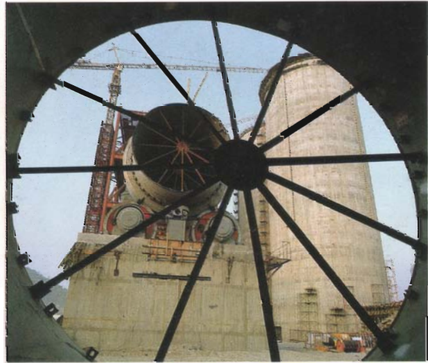
การผลิตปูนซีเมนต์จากหม้อเผาที่มีขนาดใหญ่ที่สุดในโลก ที่โรงงานเขาวง จังหวัดสระบุรี ขณะนี้อยู่ในระหว่างการติดตั้ง เครื่องจักร จะเริ่มผลิตได้กลางปี 2536
