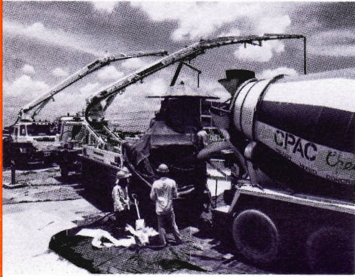
บน: คอนกรีตกำลังอัดสูงของบริษัทผลิตภัณฑ์และวัสดุก่อสร้าง เหมาะสำหรับอาคารขนาดใหญ่ที่ต้องการเพิ่มพื้นที่ใช้สอยลดต้นทุนโดยรวมและลดเวลาในการก่อสร้าง
