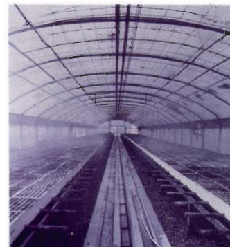
ระบบการให้น้ำแบบเปิดปิดโดยอัตโนมัติ ในโรงเรือนเพาะชำ ของบริษัทสยามฟอเรสทรี จำกัด ที่จังหวัดกาญจนบุรี กล้าไม้เหล่านี้เป็นส่วนหนึ่งของวัตถุดิบที่จะใช้ในการผลิตเยื่อกระดาษต่อไป
