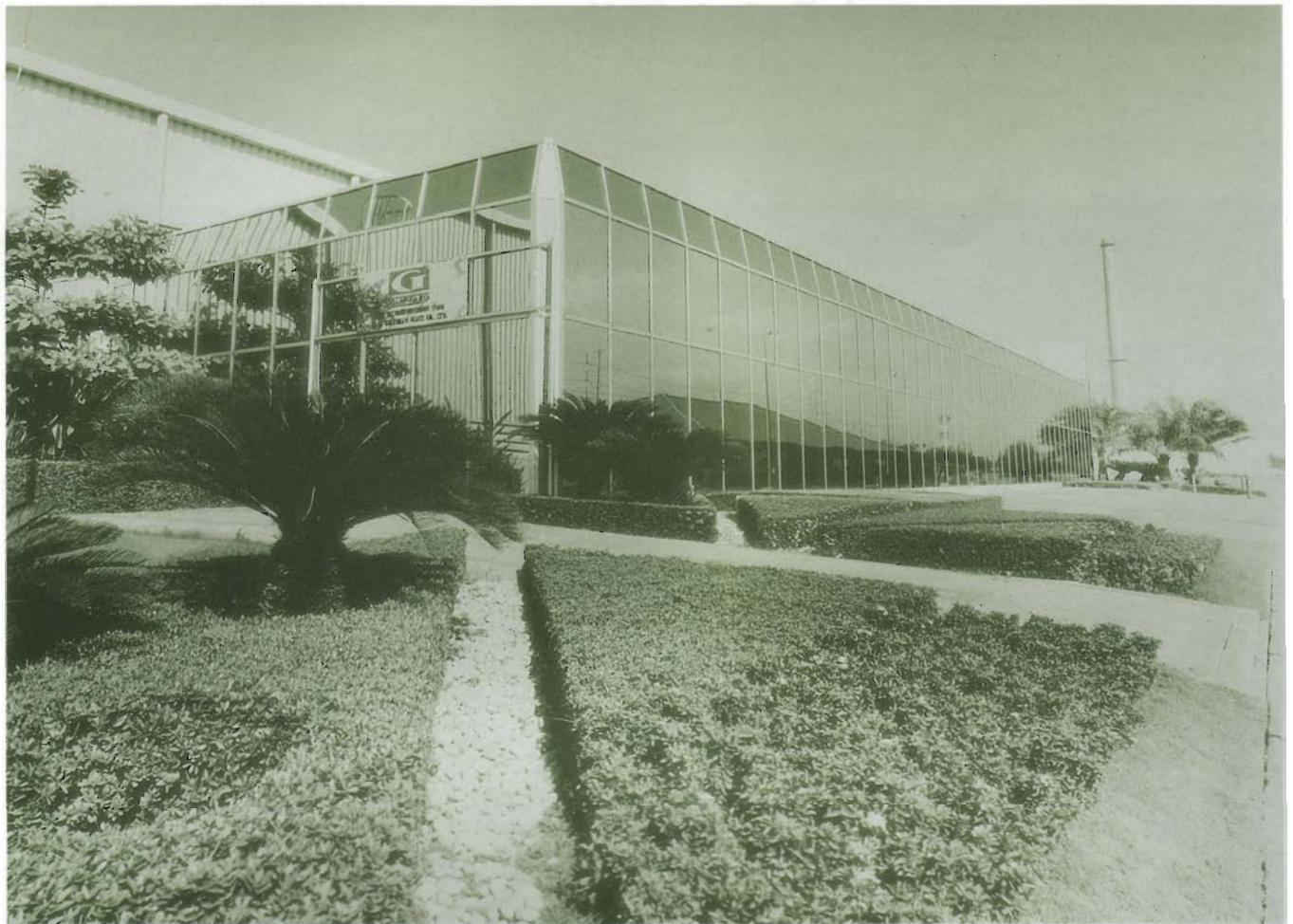
บริษัทกระเจกสยามการค้า จำกัด ได้รับการรับรองระบบคุณภาพ ISO 9002 ในการผลิตกระเจกใส จาก British Standards Institute (BSI) ในปี 2538 และได้ตั้งโรงงานกระเจกแห่งที่ 2 ชื่อ บริษัทกระเจกสยามการค้า (ระยอง) จำกัด โดยได้รับการส่งเสริมการลงทุน คาดว่าจะเริ่มผลิตได้ในปี 2540
