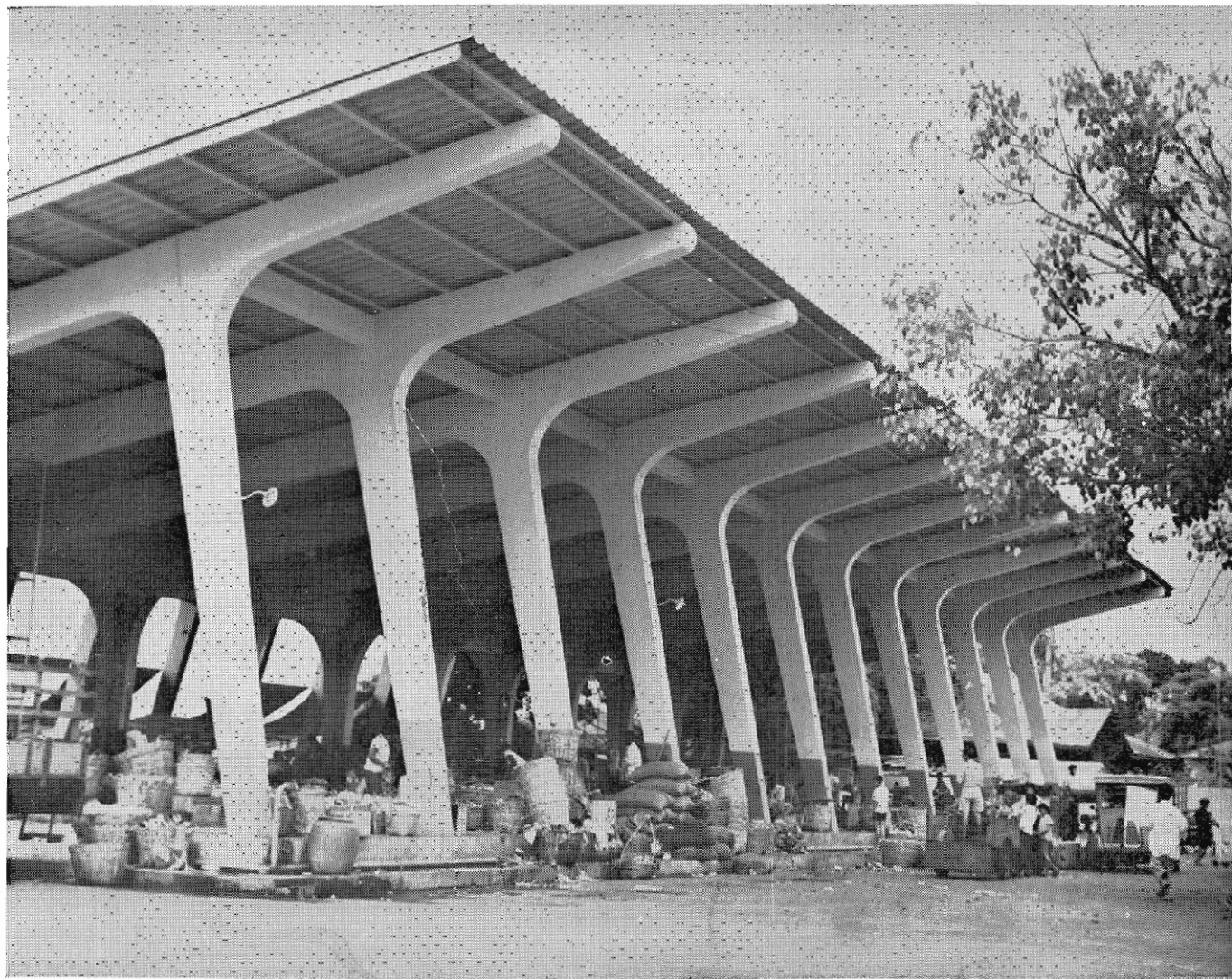
ตลาดทันสมัยสร้างด้วยคอนกรีตเสริมเหล็ก Modern Market executed in Reinforced Concrete.
