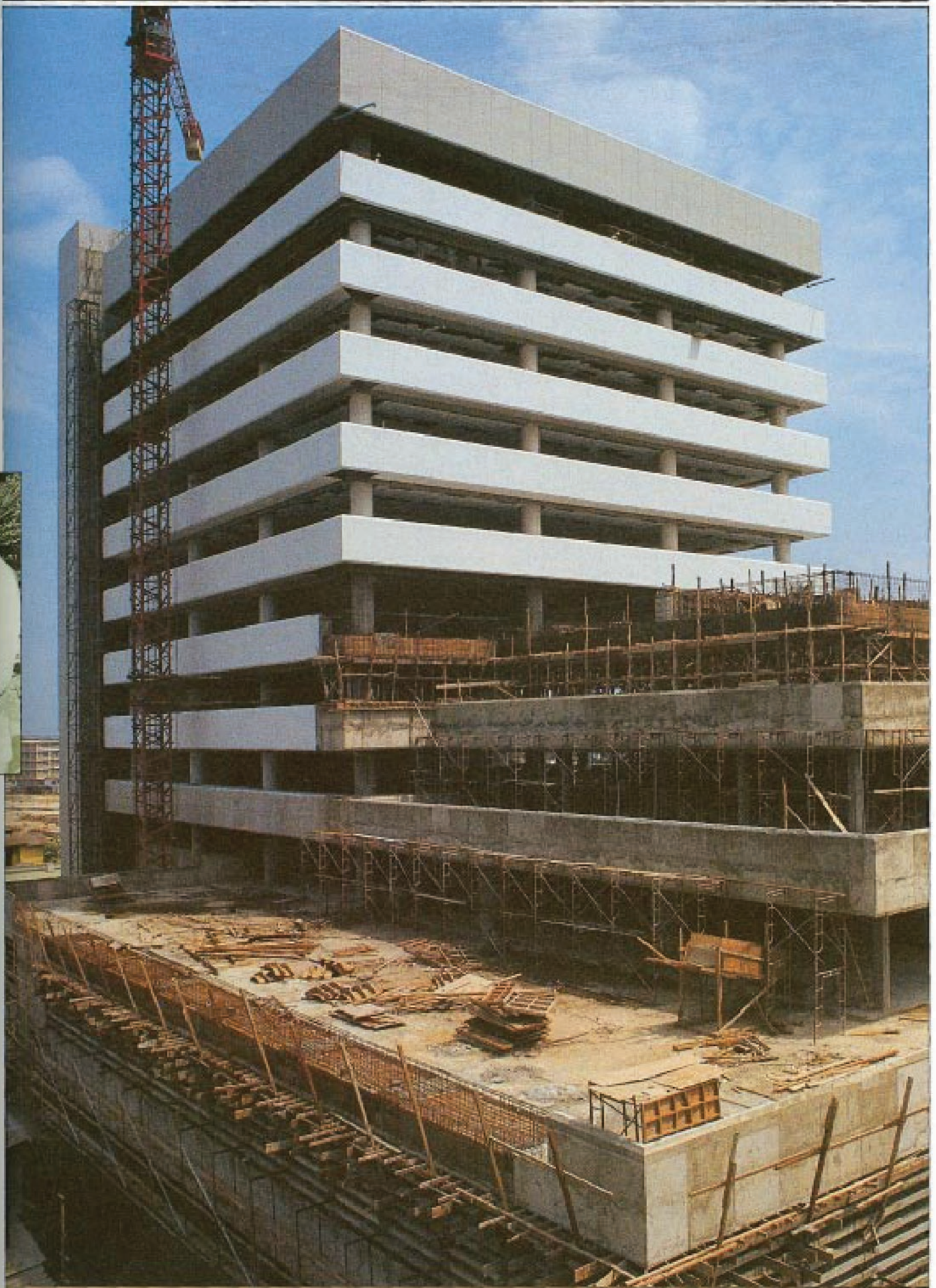
(ซ้าย) พิธีวางศิลาฤกษ์อาคารสำนักงานใหญ่หลังใหม่ พ.ศ. 2525 (บน) การก่อสร้างใกล้แล้วเสร็จ
