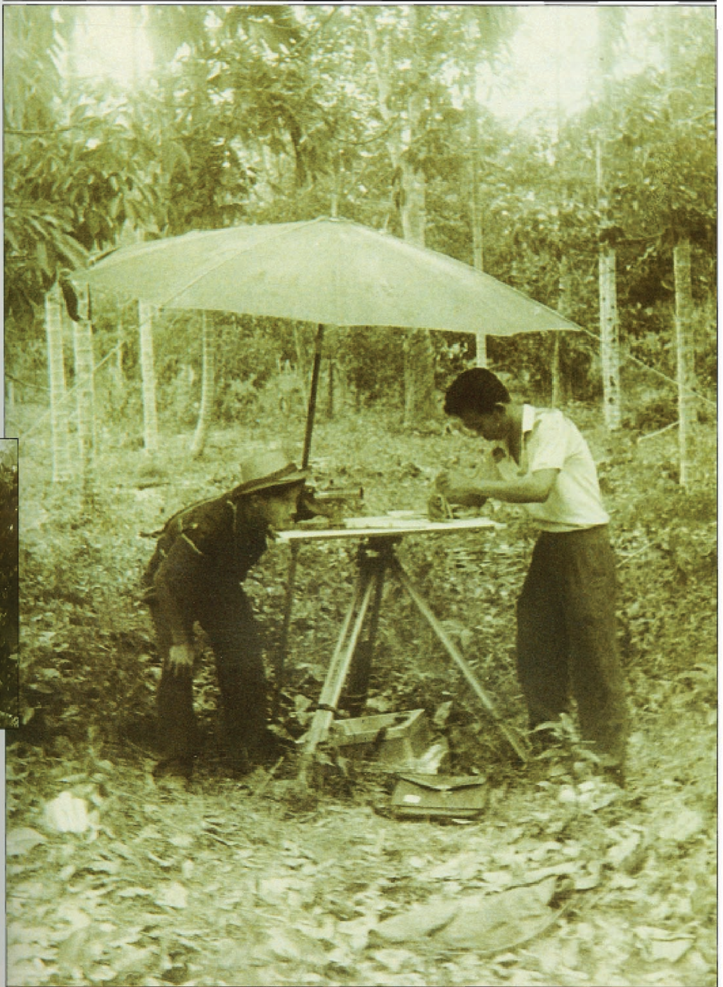
(ซ้าย) พุ่งลงใน พ.ศ. 2506 (๒๒๘) สักรวจพื้นที่ก่อสร้างโรงงานปูนซีเมนต์ทุ่งสง
