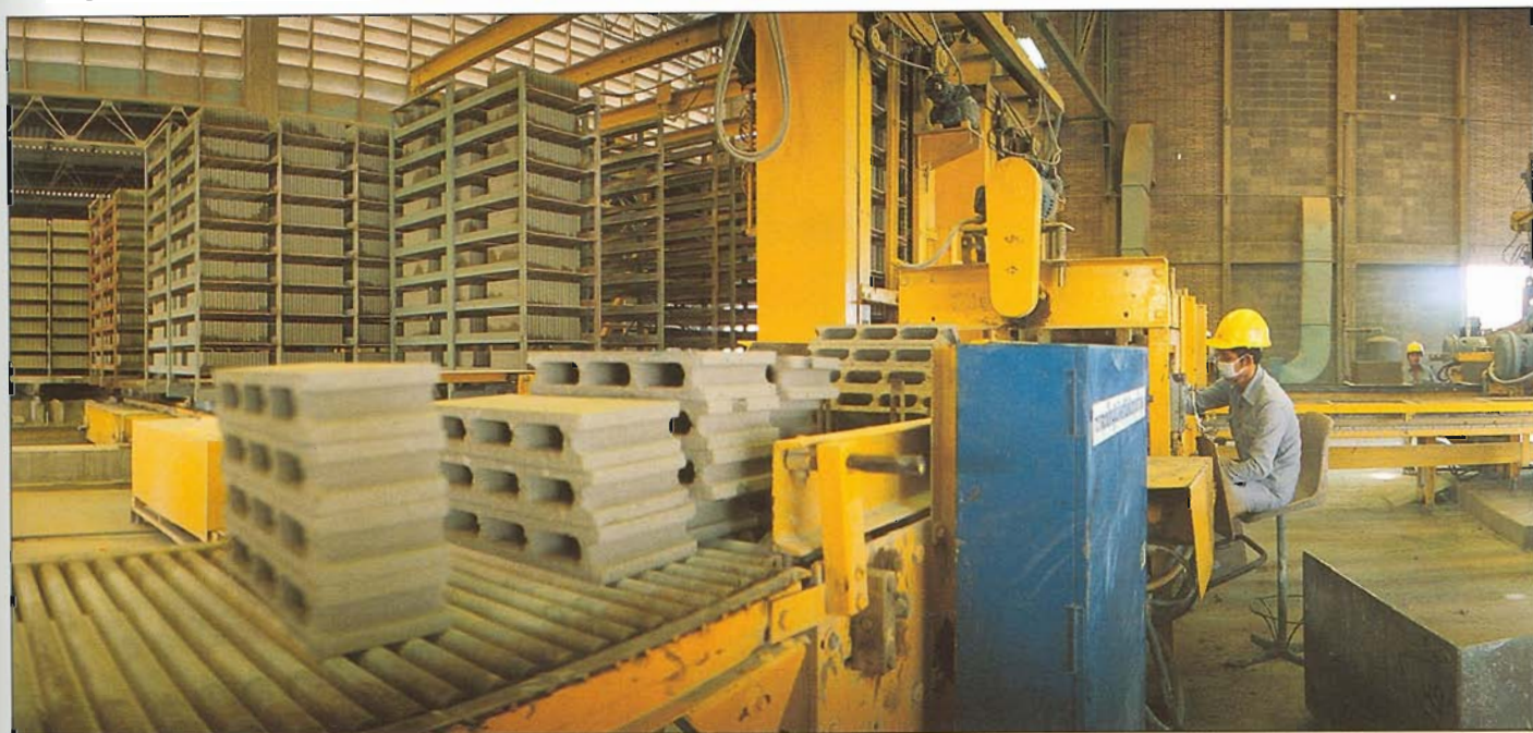
ส่วนหนึ่งของโรงงานผลิตภัณฑ์คอนกรีตสำเร็จรูป นนทบุรี
